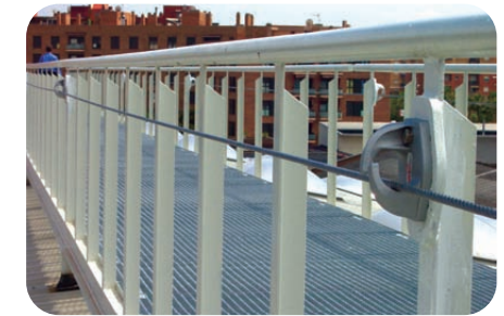
Detalle montaje placas PS14 sobre estructura metálica
