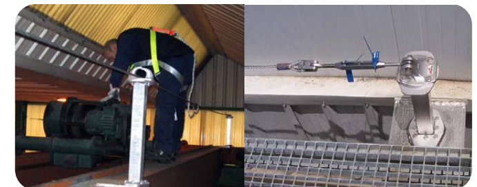
Detalle montaje columna poste sobre puente grúa
