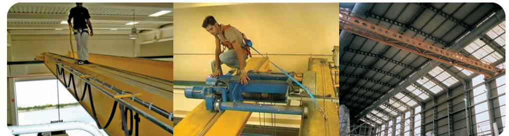
Detalle montaje placas PS14 sobre puente grúa
